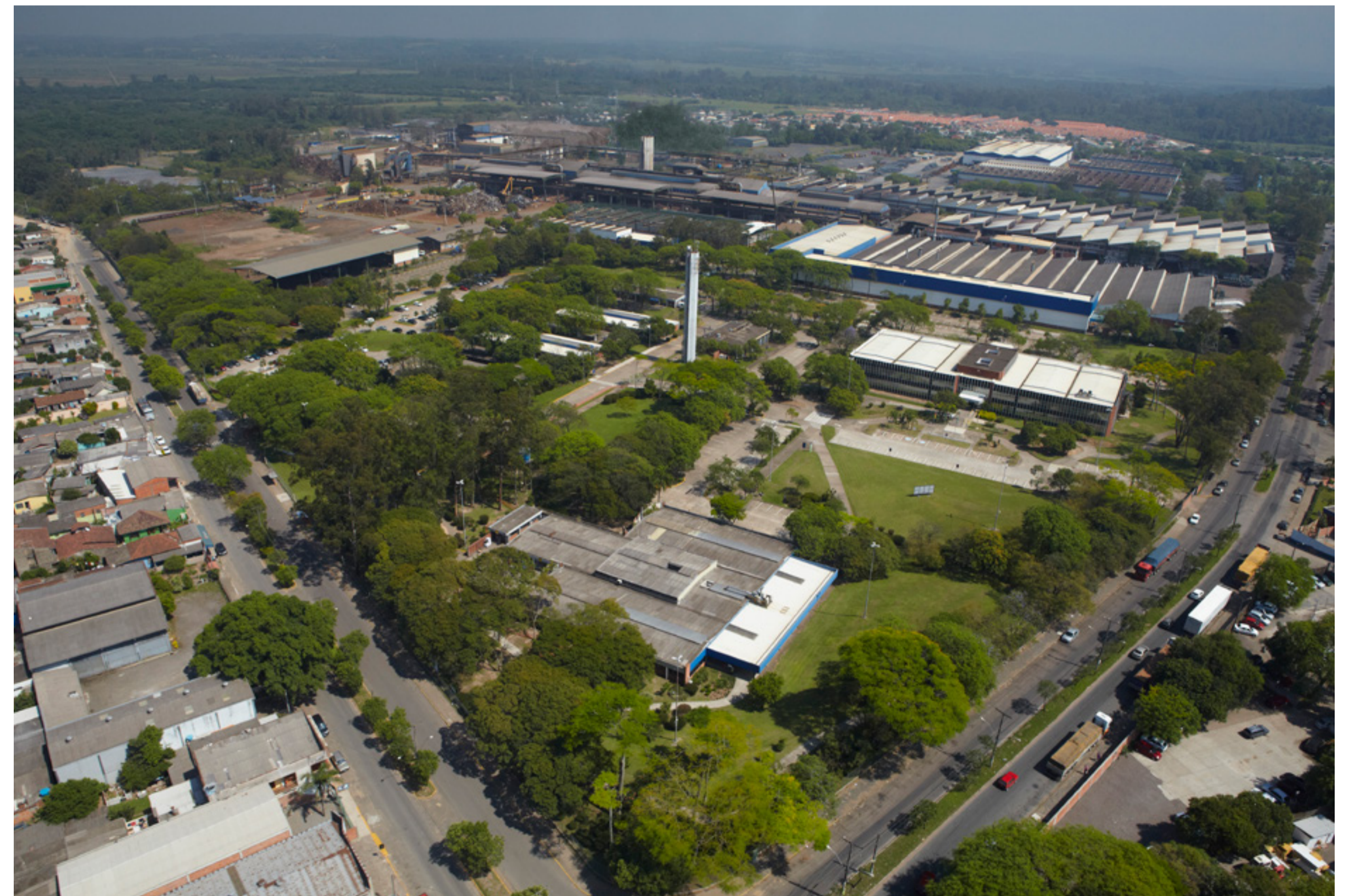
Usina Gerdau Riograndense, Sapucaia do Sul (RS)
